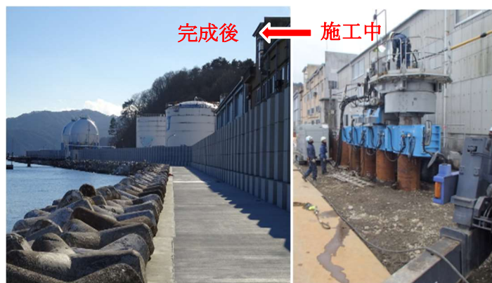
災害復旧・防災工事の施工例
