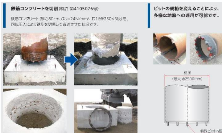
鉄筋コンクリート構造物へ圧入
